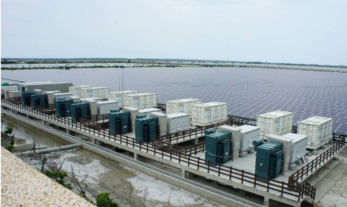
台南七股鹽田儲能系統為台灣最大的太陽能電站利用儲能系統平衡輸出案場，此儲能系統由聯合再生能源股份有限公司(3576 TT)承包建置，系統建置容量為 15MW/15MWh，除具備調頻輔助服務(AFC)外，也提供南鹽田光電場的太陽能發電平滑輸出(PV Smoothing)功能，並且穩定台灣電網系統頻率，也同時利用儲能系統來平穩太陽能電站發電功率，提高太陽能電站運轉效率，此系統目前已併網啟用。
